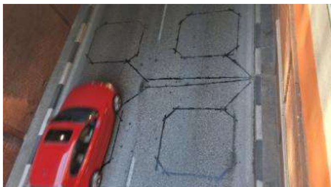
Equipo de aforo por espiras electromagnéticas
